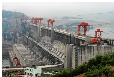
איור 18 - תחנת כוח הידרואלקטרית בסכר
